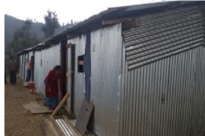
Provisorisches Lern-Zentrum aus Wellblech
