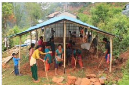
Bau eines Behelfs-Klassenzimmers
