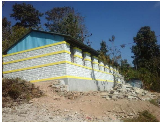
Tikhatal, nach der Reparatur
