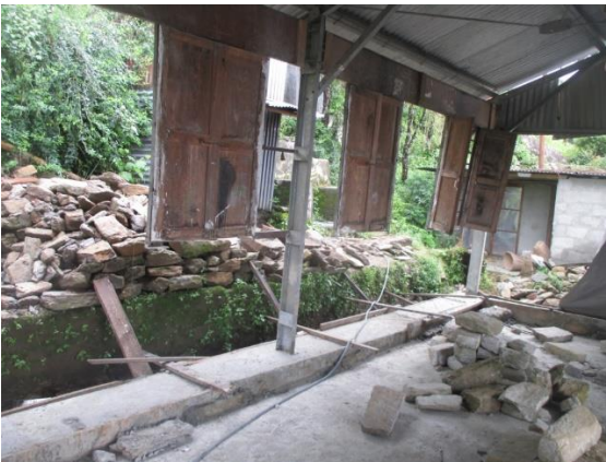
Tikhatal, vor der Reparatur
